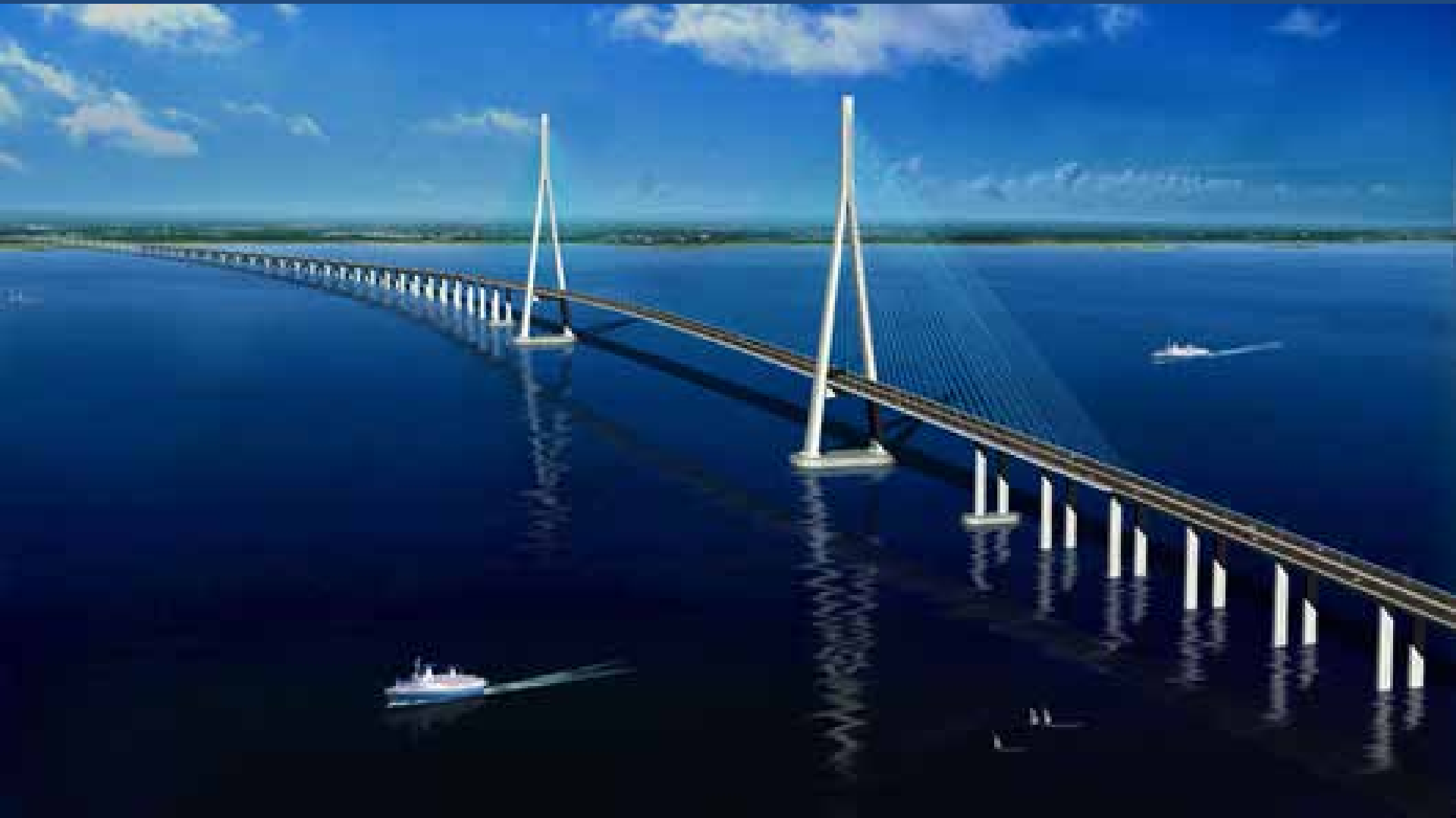
Le Pont de Sutong sur le Yang-Tseu-Kiang – Portée de la Travée Principale: 1088 m
