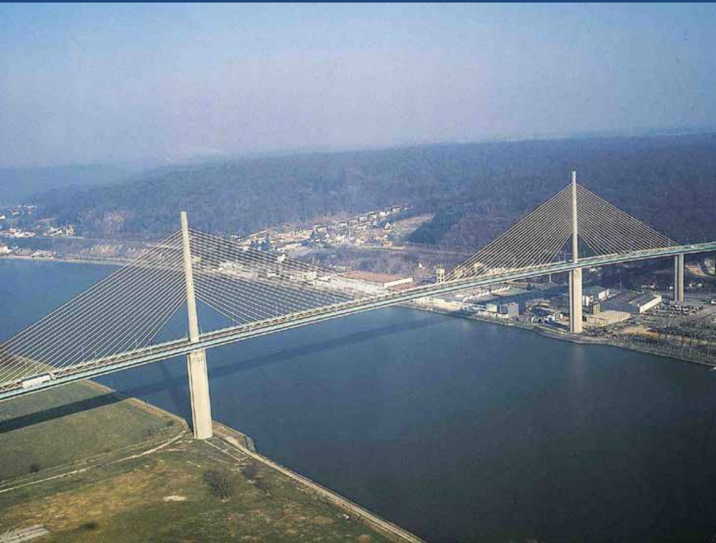
Le Pont de Brotonne – Portée de la Travée Principale : 320 m
