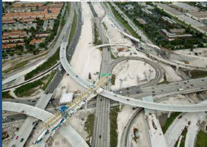
Section 5 - SR-826/836 Interchange EIN # 249581-1-5200, 249581-1-5299
