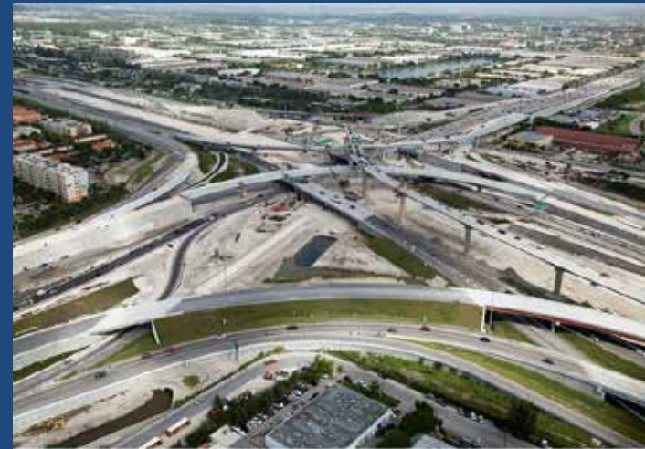
Section 5 - SR-826/836 Interchange EIN # 249581-1-5200, 249581-1-5299
