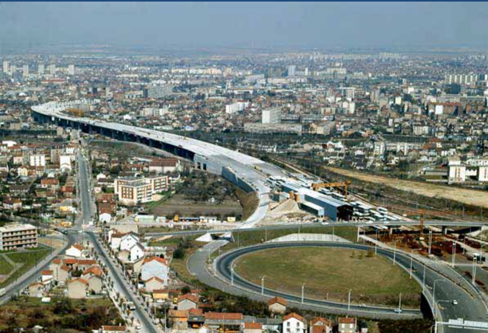
Les Viaducs B3 Sud (Autoroute A3) – 2200 voussoirs préfabriqués
