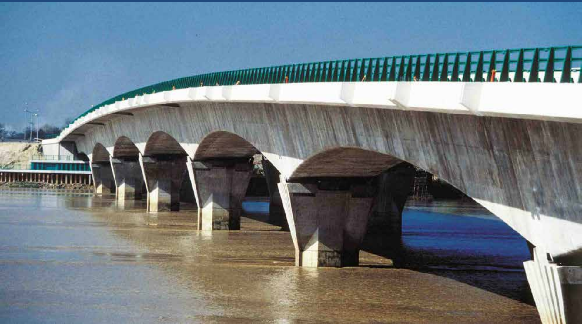
Le Pont François Mitterrand (Arcins) – Portées: 63 m – 5 x 102 m – 69 m
