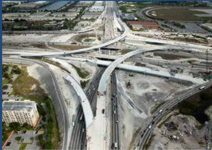
Section 5 - SR-826/836 Interchange EIN # 249581-1-5200, 249581-1-5299
