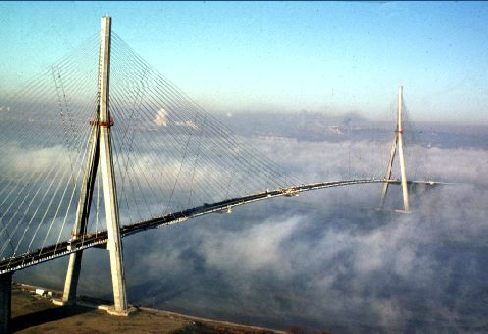
Le Pont de Normandie – Portée de la Travée Principale: 856 m
